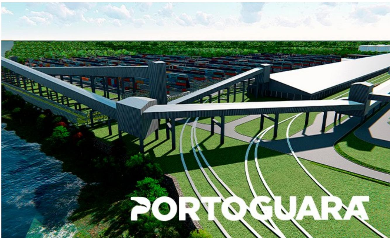
Malha ferroviária interna de aproximadamente 21km, dividida em ramais que permitem manobras de carga e descarga dos vagões sem a necessidade de quebra das composições ou interrupção das vias rodoviárias. A infraestrutura projetada permite a movimentação de até 70% das cargas pelo modal ferroviário.
